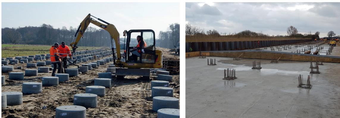
typengeprüften Pfahl. Die werkseitige Herstellung gewährleistet einheitliche Betonquerschnitte und -eigenschaften sowie eine planmäßig ausgeführte Bewehrungslage mit Toleranzen von +/-3 mm. Wichtige Systemvorteile liegen außerdem in den kurzen Einbauzeiten und der vollständigen Witterungsunabhängigkeit auf der Baustelle sowie der sofortigen Prüf- oder Überbaubarkeit.
