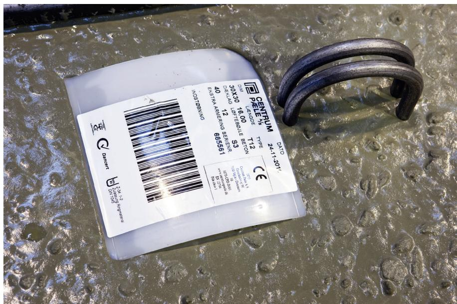
**Abb. 3:** Werkseitige Plakette mit allen relevanten Pfahldaten
