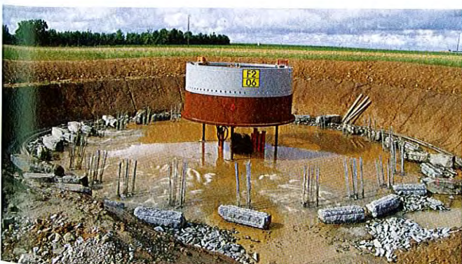
Bild 3. Kappungsarbeiten
