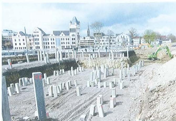
Bild 1 Eingebaute Pfähle Bauteil Süd
