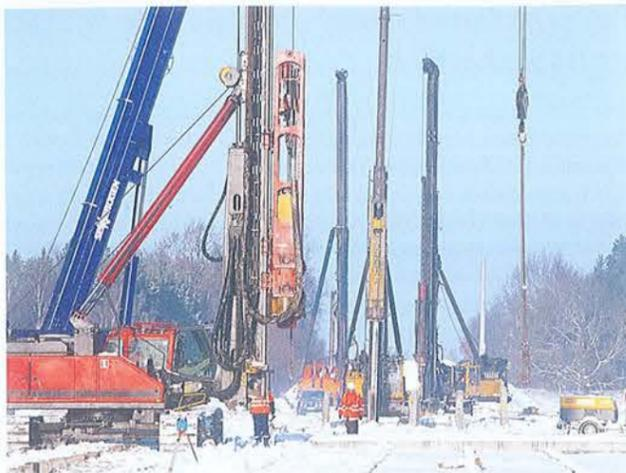
**Bild 1.** Arbeiten auf engstem Raum – Auch in dem langen, kalten Winter 2012/2013 brachten die hochmodernen Centrum-Hydraulikrammen die vorgefertigten Pfähle tadellos in den gefrorenen Boden ein.
