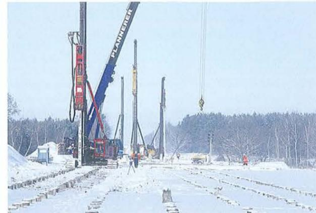
**Bild 2.** Die Rammgeräte waren innerhalb der Linienbaustelle bisweilen nur wenige Meter voneinander entfernt im Einsatz.
