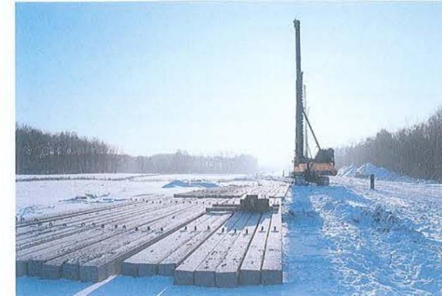
**Bild 3.** Ramm- und Pfahllager (Fotos: Centrum Pfähle)
