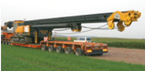
1. Anlieferung des Rammgerätes
