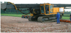
2. Entladung des Rammgerätes
