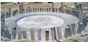
9. Kreisfundament nach Rammung und Aushub
