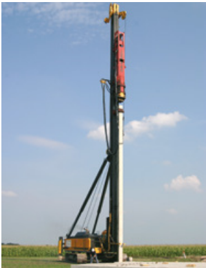
6. Hochziehen eines Pfahles
