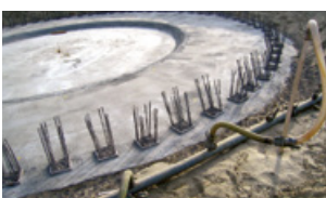
10. Kreisfundament nach den Kapparbeiten
