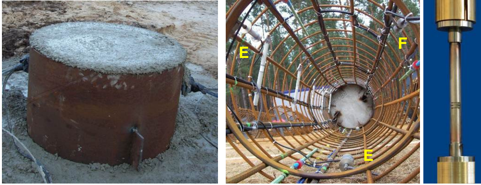
Abbildung 7: Links: instrumentierter Bohrpfehl im zweiten Testfeld, Mitte: Bewehrungskorb mit zwei EFPI-Sensoren (E) und einem FBG-Sensor (F) pro Messebene, rechts: temperaturkompensierter FBG-Sensor.
